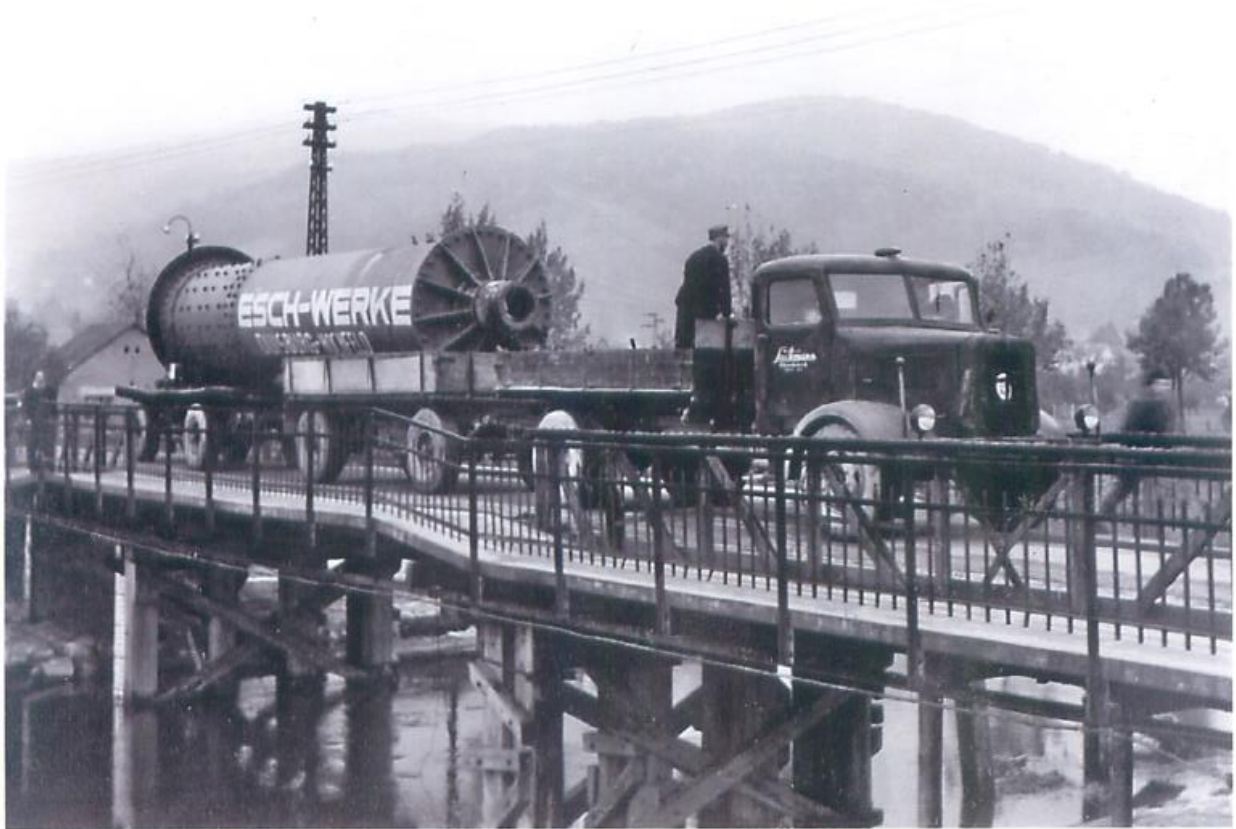
1953 Transport der Kugelmühle vom Oberkircher Bahnhof nach Hesselbach Behelfsbrücke über die Rench - die alte Brücke wurde 1945 kurz vor Kriegsende von Wehrmachts-Pionieren gesprengt
