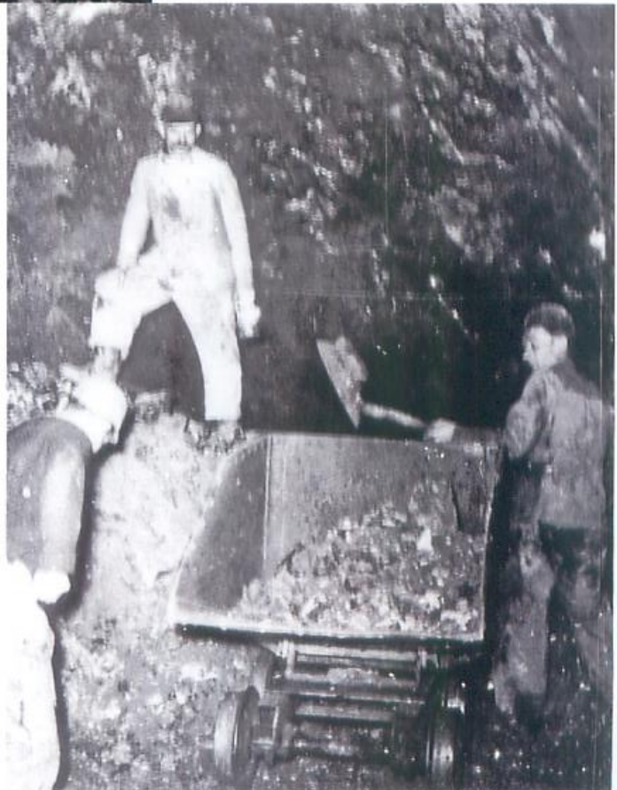
Nach der Sprengung: Abschlag verladen
