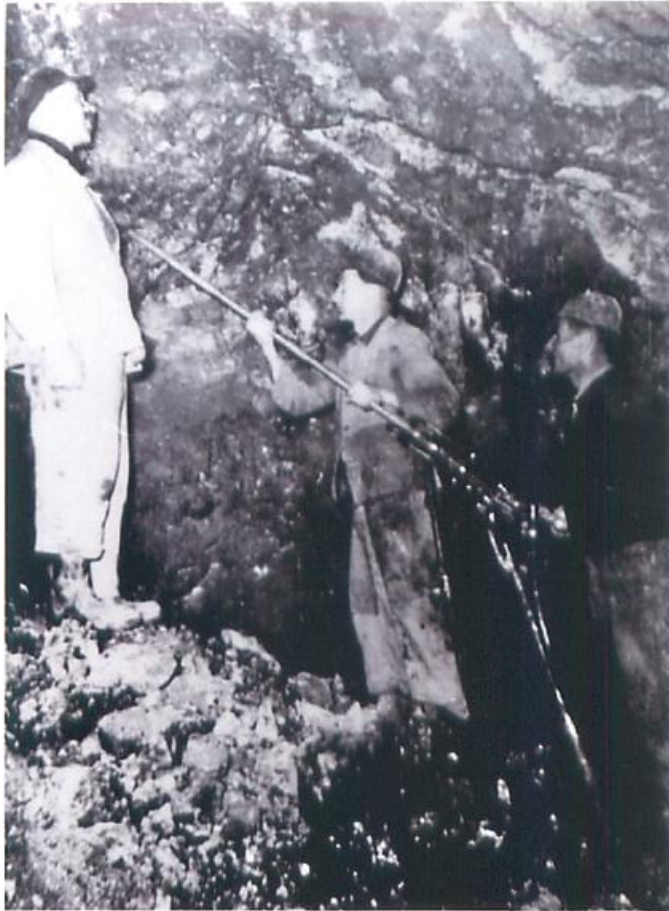
Bohren der Sprenglöcher
