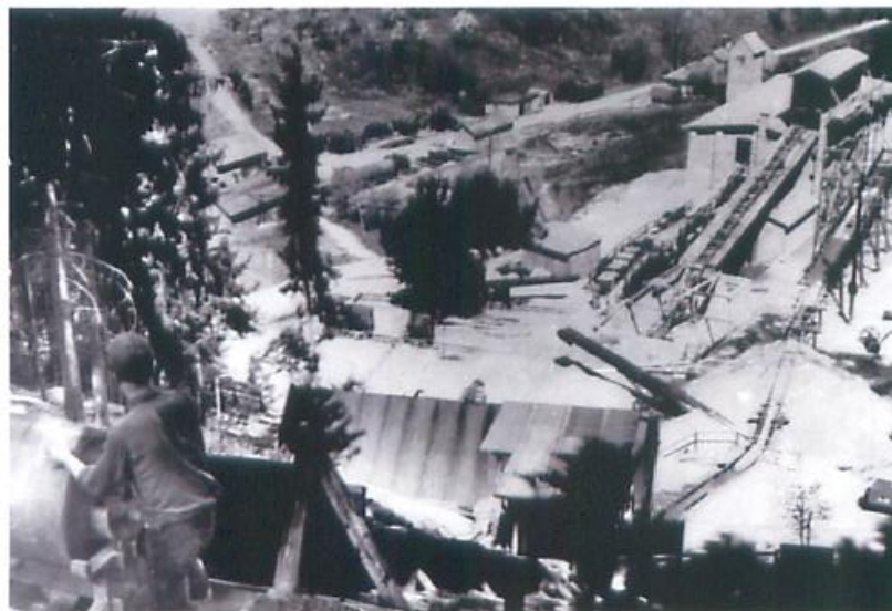
Förderwagen werden in Aufgabtrichter der Rutsche entleert
